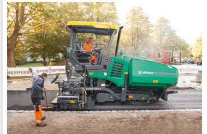
ПРОКЛАДКА ДОРОЖЕК В ПАРКОВЫХ ЗОНАХ
