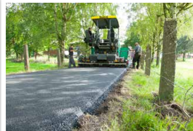
РЕМОНТ ПОДЪЕЗДНЫХ ДОРОГ
