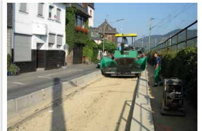
РЕМОНТ ГОРОДСКИХ ДОРОГ
