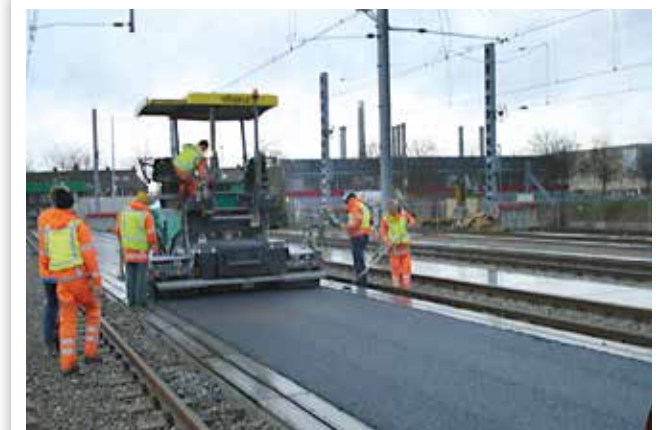
УКЛАДКА АСФАЛЬТА НА ПЕРРОНАХ
