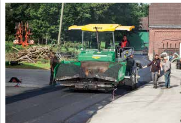
УКЛАДКА АСФАЛЬТА В ПРОМЫШЛЕННЫХ ЗОНАХ
