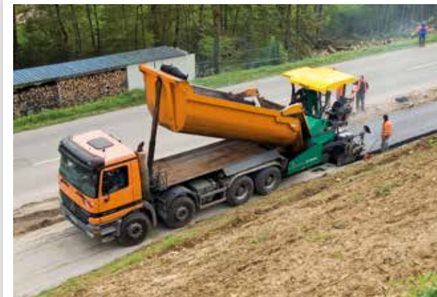
УКЛАДКА АСФАЛЬТА НА ТРОТУАРАХ С ВЕЛОСИПЕДНЫМИ ДОРОЖКАМИ
