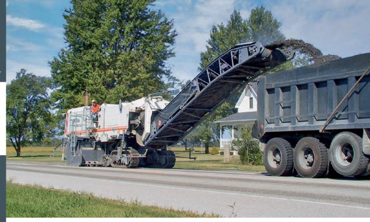
Концепция машины двойного назначения обеспечивает эффективную работу в качестве высокопроизводительной холодной фрезы.
