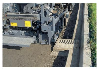
Встроенная система автоматического нивелирования обеспечивает точную укладку смеси переработанного материала до заданного уровня. Образовавшийся слой является идеальным основанием для последующей укладки нового асфальтобетонного покрытия. Среди различных преимуществ машины можно также отметить гидравлически открываемый боковой щит рабочего органа, который позволяет перенаправить излишки материала для укрепления обочины.
