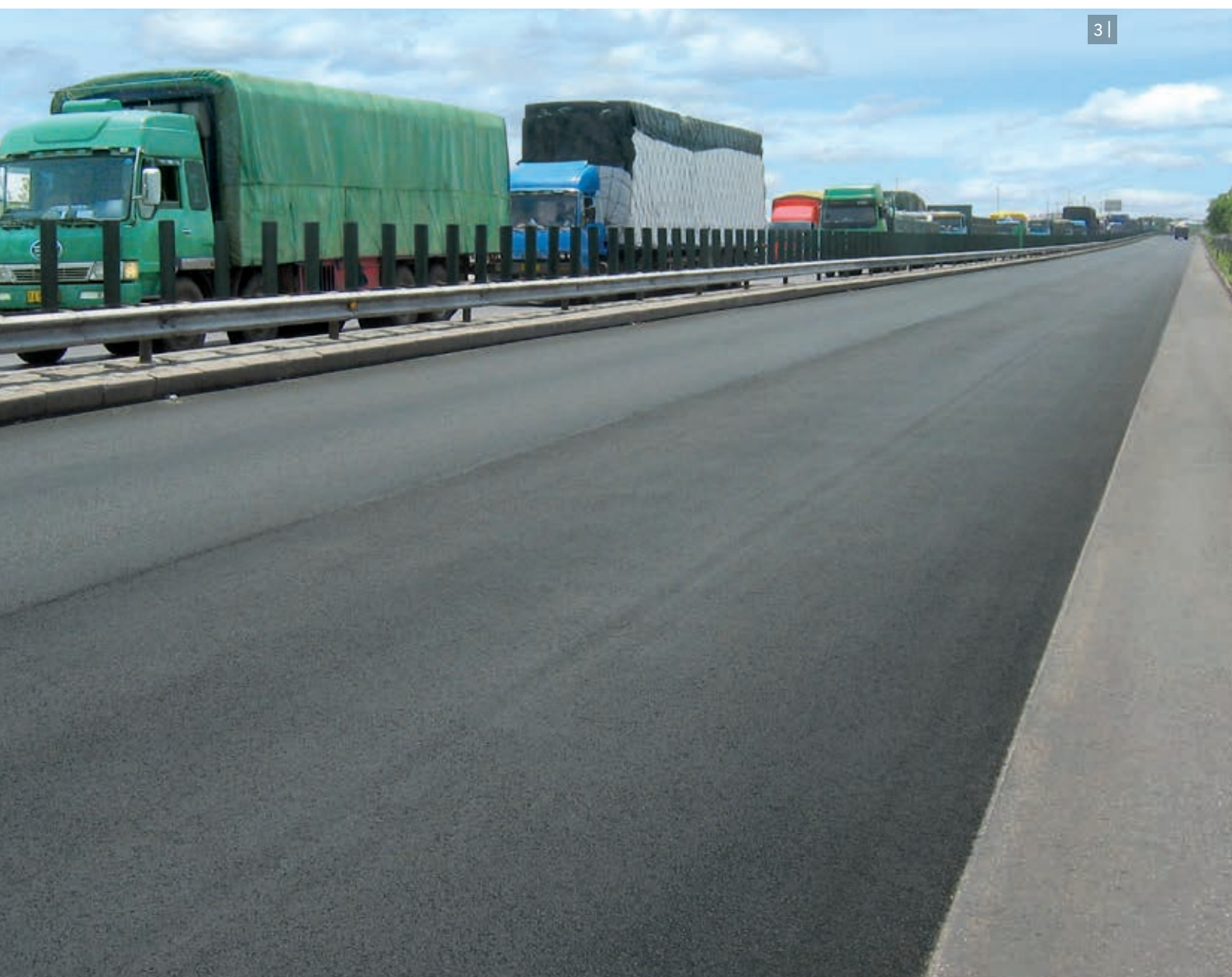
3 | Проезжая часть из холодной смеси с двумя полосами движения без поверхностной обработки.
