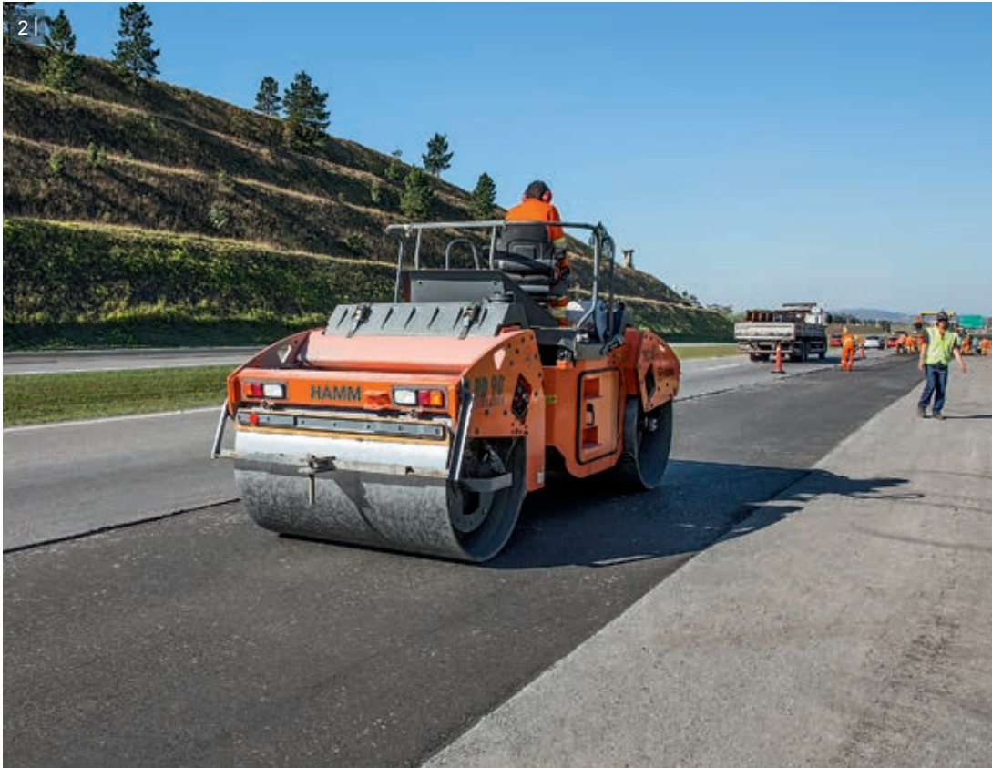
3 | Проезжая часть из холодной смеси с двумя полосами движения без поверхностной обработки.
