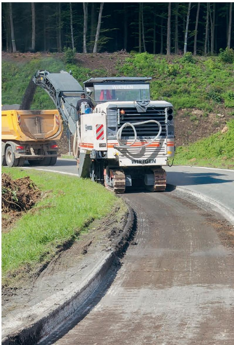
1 | Благодаря высокопроизводительной загрузке материала W 220 без проблем справляется с фрезерованием значительных объемов материала на стройплощадках.
